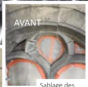
Sablage des façades
